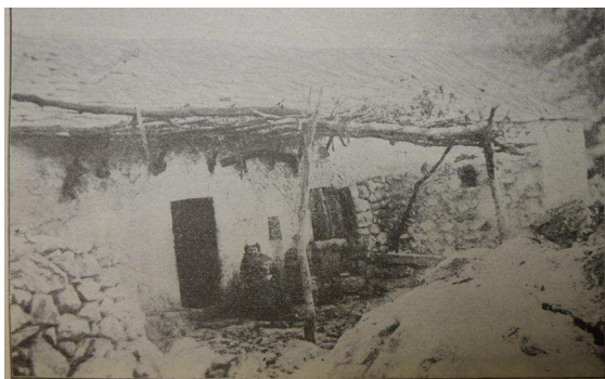
Dedijer: Pločna kuća u Ljubovu u Površi
