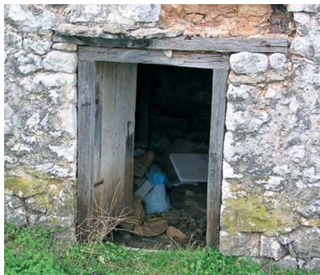
Slika 9: Okviri oko otvora su drveni, 2008.
