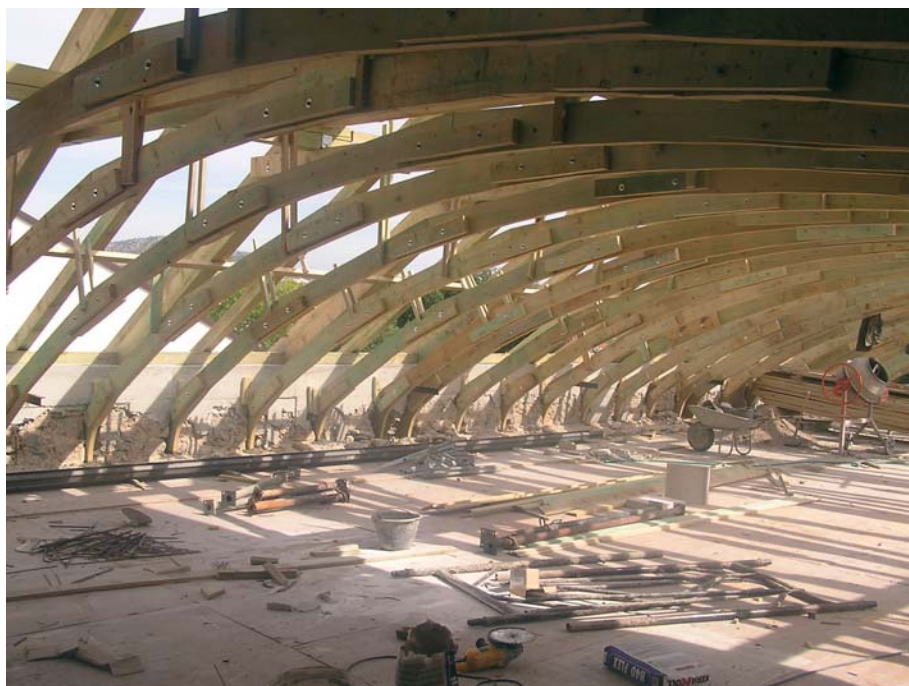
Slika 10: Gradnja drvene stropne konstrukcije
