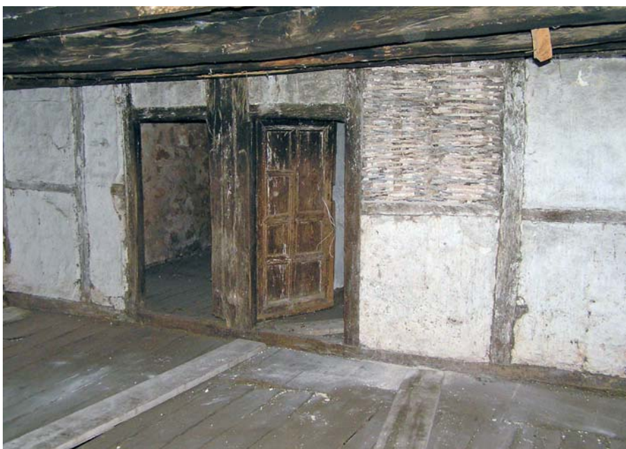
Slika 11: Većina unutarnjih zidova je ožbukana, ovisno o namjeni prostora
