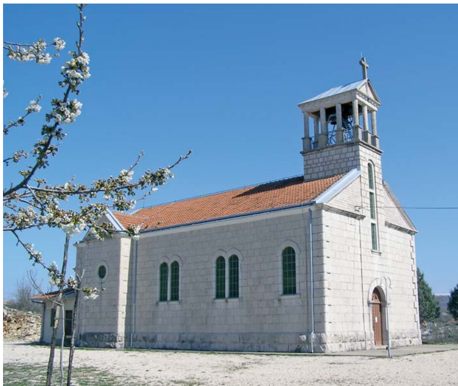
Slika 7: Bočno pročelje rašanjske crkve
