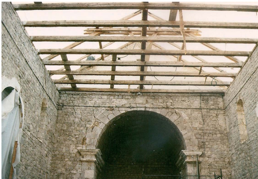
Slika 6: Postavljanje nove krovne konstrukcije
