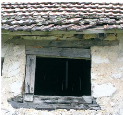
Slika 9: Okviri oko otvora su drveni, 2008.
