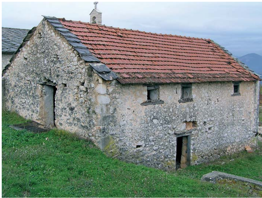
Slika 12: Južno i istočno pročelje prije obnove
