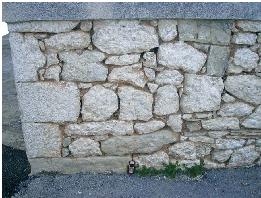
Slika 9: Način zidanja na uglovima crkve
