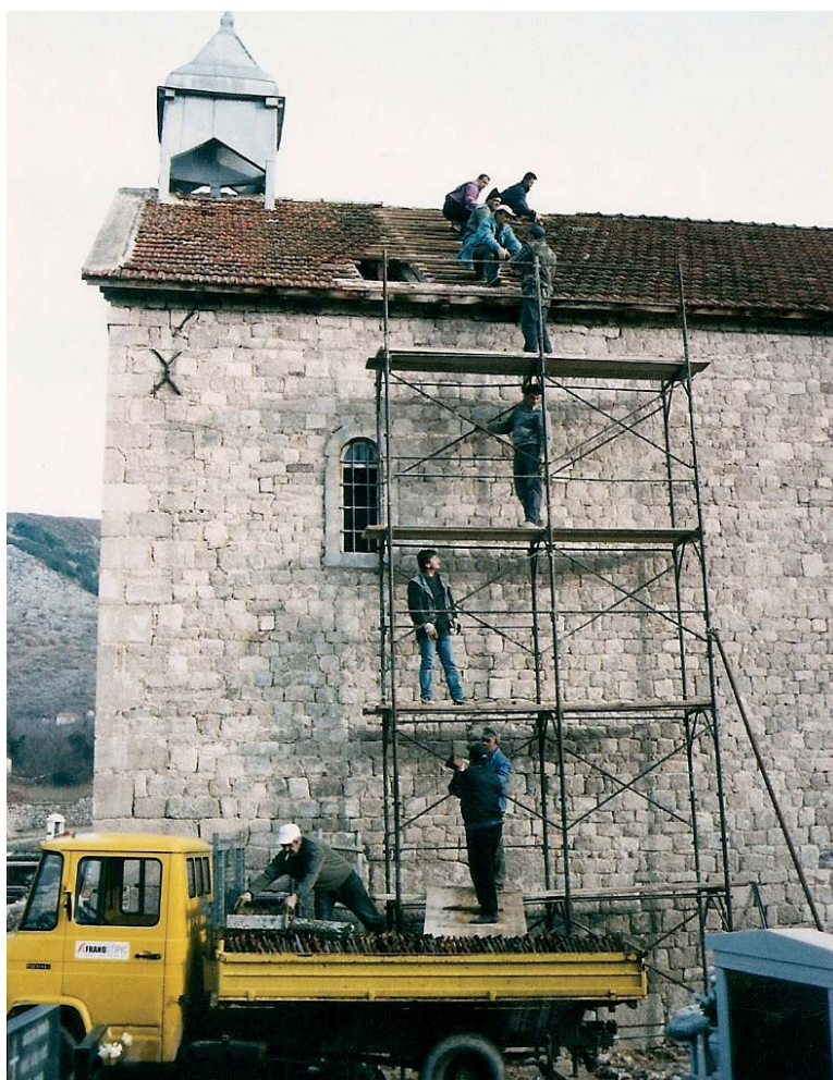
Slika 7: Početci radova na rekonstrukciji crkve 1999.
