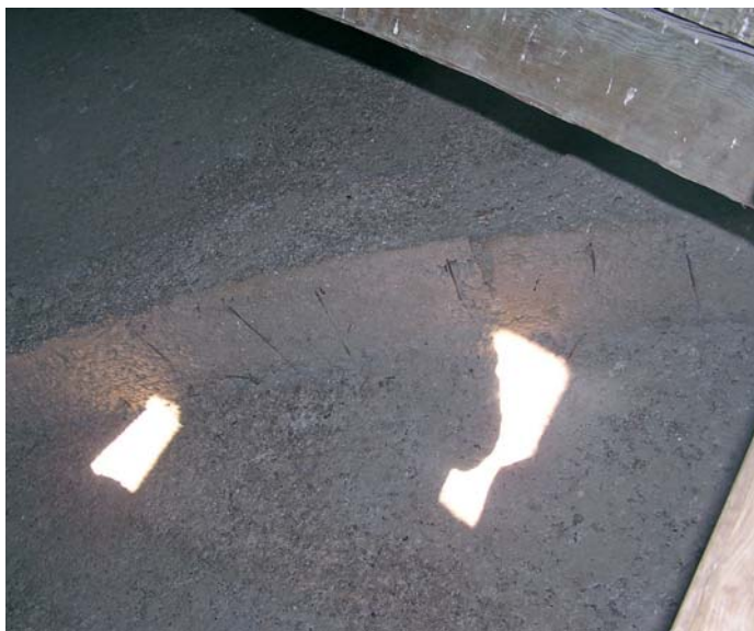
Slika 14: Tanki zaštitni slojevi armature
