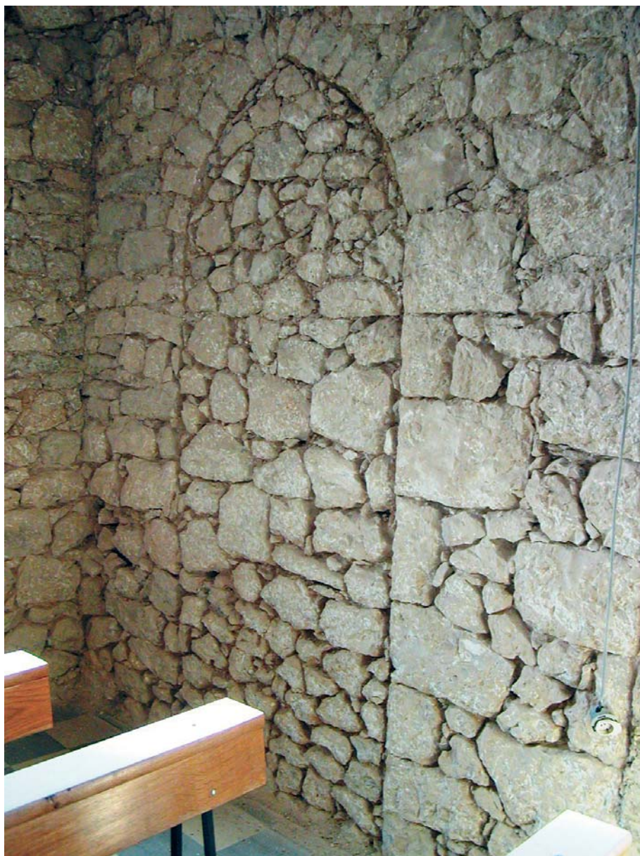
Slika 10: Unutarnji zid crkve s karakterističnim obzidavanjem otvora
