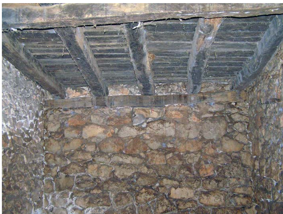
Slika 7: Izgled unutarnjih kamenih zidova
