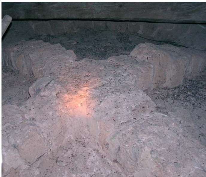
Slika 13: Kameni križni svod (iznad bočnih lađa)
