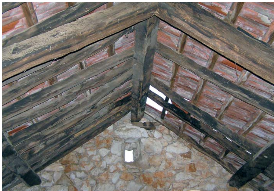
Slika 8: Kuća ima drvenu dvostrešnu krovnu konstrukciju
