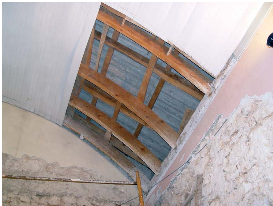
Slika 14: Daščani nosači bačvastog svoda crkve
