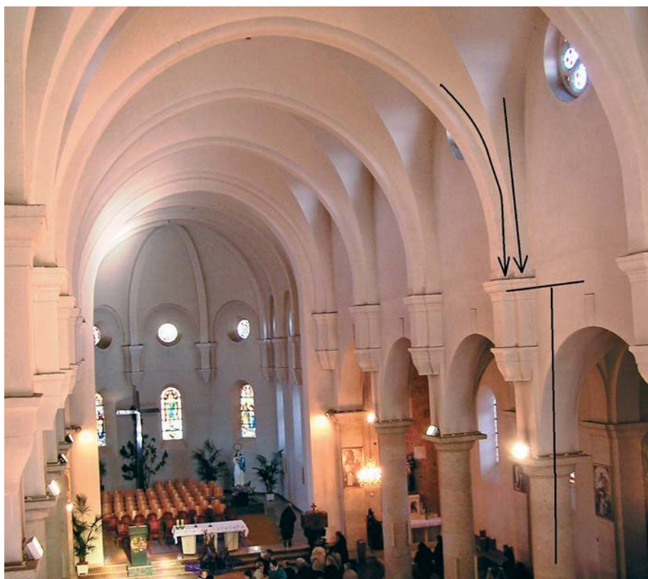
Slika 18: Tijek sila sa svoda na stup crkve
