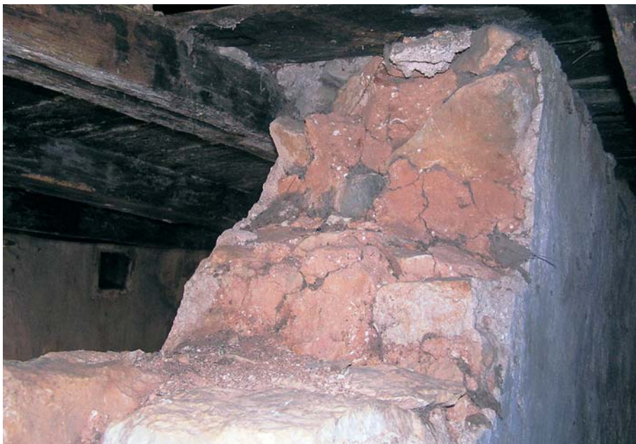
Slika 10: Vezivni materijal pri zidanju, tzv. "meljta", mješavina vapna i crvenice
