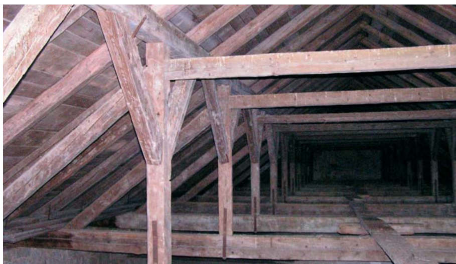
Slika 15: Dio krovne konstrukcije
