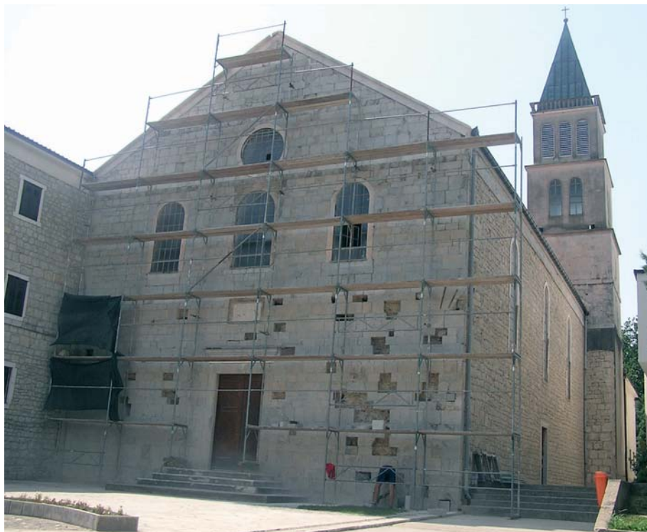
Slika 8: Zamjena oštećenih kamenih blokova na pročelju
