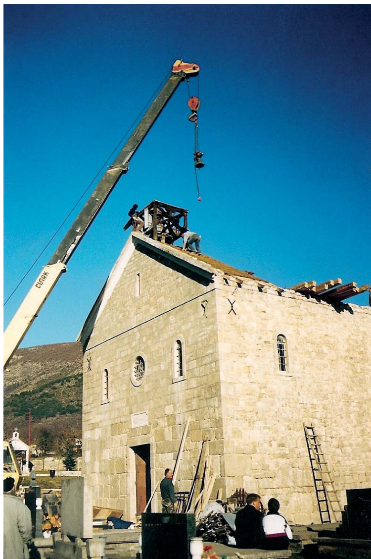
Slika 9: Radovi na rekonstrukciji zvonika
