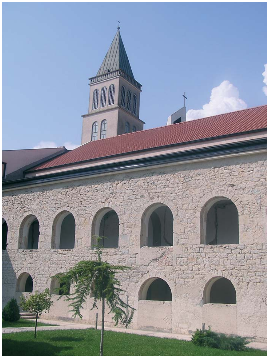
Slika 7: Južna strana crkve nakon skidanja stare žbuke
