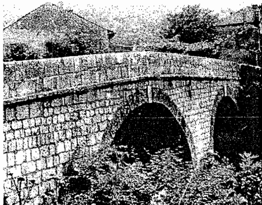
Podgradska ćuprija – nizvodna strana. Na vijencu se odražava prelom nivelete nad oba svoda.
