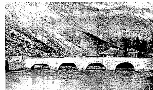
Ćuprija u Begovini – nizvodna strana. Vide se popravci betonom na dva luka uz desnu obalu i na ogradi. U pozadini Rizvanbegovića konaci u Begovini.
