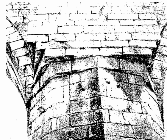
Plastika centralnog stuba s nizvodne strane
