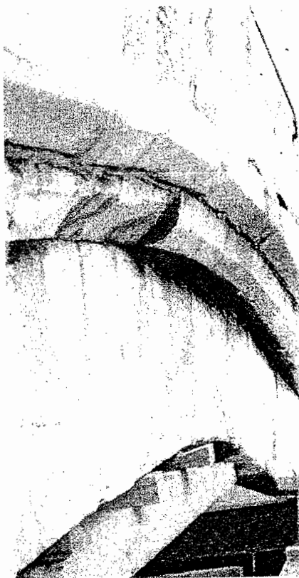
Plastične profilacije nad tjemnom svoda
