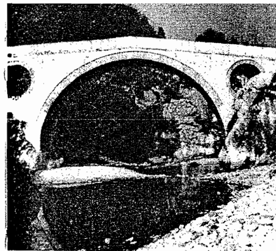
Na Kozjoj čupriji kod Sarajeva vidimo izrazito traženje kolorističkih efekata, koji proizlaze iz primjene dvaju materijala: sedre i bijelog krečnjaka.
