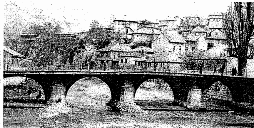
Današnji izgled mosta sa uzvodne strane
