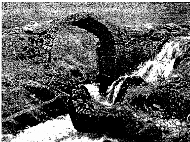
Logika konstrukcije svoda – ostaci seoskog mostića u Bodežanima (svod upet između dvije priobalne stijene govori o iskonskom umijeću kamenara u realiziranju stereotomske forme).
