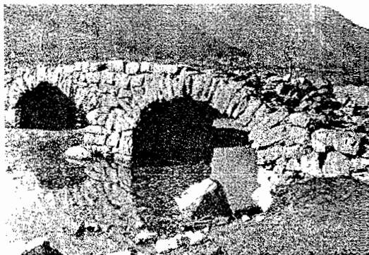
Ljubomir – Ugarci. Most na dva svoda od kamena lomljenjaka, izveden u suhozidini. Nečovoljnc definirana forma tendira niskom pritisnutom luku..
