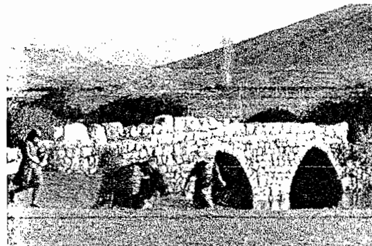
Mostači kod Trebinja – Seoska rustikalna forma mosta, čiji svodovi oblikovano tendiraju prelomljenju luku.
