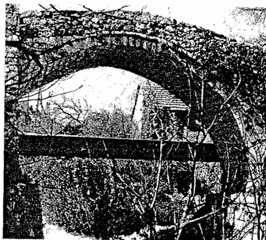
Kriva ćuprija u Mostaru – nizvodna strana
