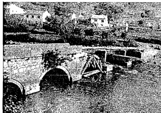
Most u toku rekonstrukcije. Na sačuvanom dijelu vidi se nadozid iz nepoznatog vremena kojim je promijenjena prvobitna niveleta.
