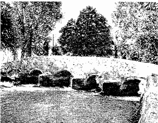
Uzvodni izgled najstarijeg stolačkog mosta
