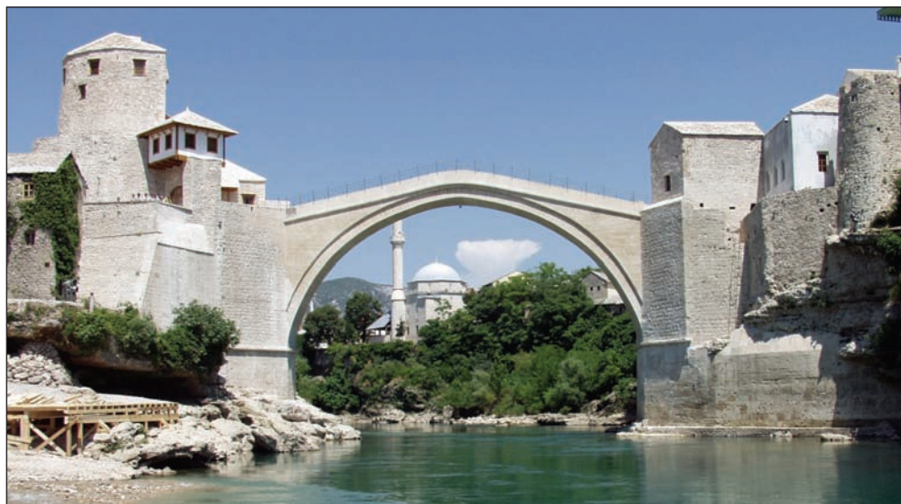
Sl. 2. Obnovljeni kompleks Staroga mosta u Mostaru
