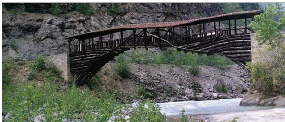
Sl. 15. Drveni most, tzv. Kiremitli (ili Hapsiyaş) Köprüsü u pokr. Trabzon u Turskoj iz 1935. godine
