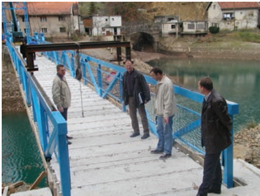
Slika 4.4: Kontrola postavljanja omnia ploča
