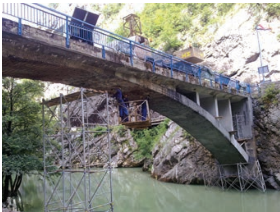
Slika 11.5: Radovi sanacije na mostu
