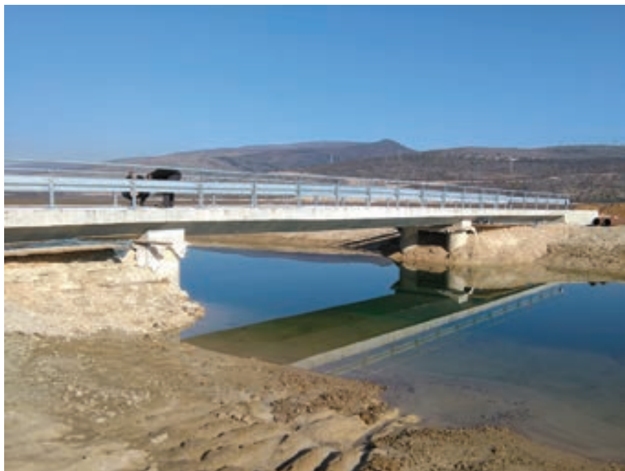
Slika 9.3: Pogled na prijelaz s istoka
