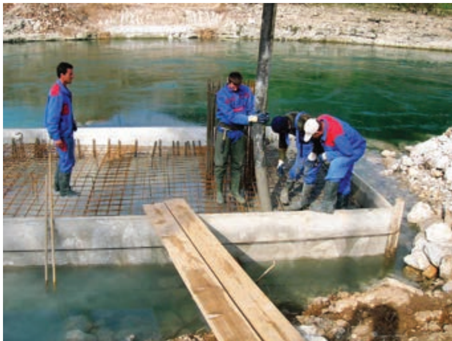
Slika 3.7: Podvodno betoniranje riječnog stupa
