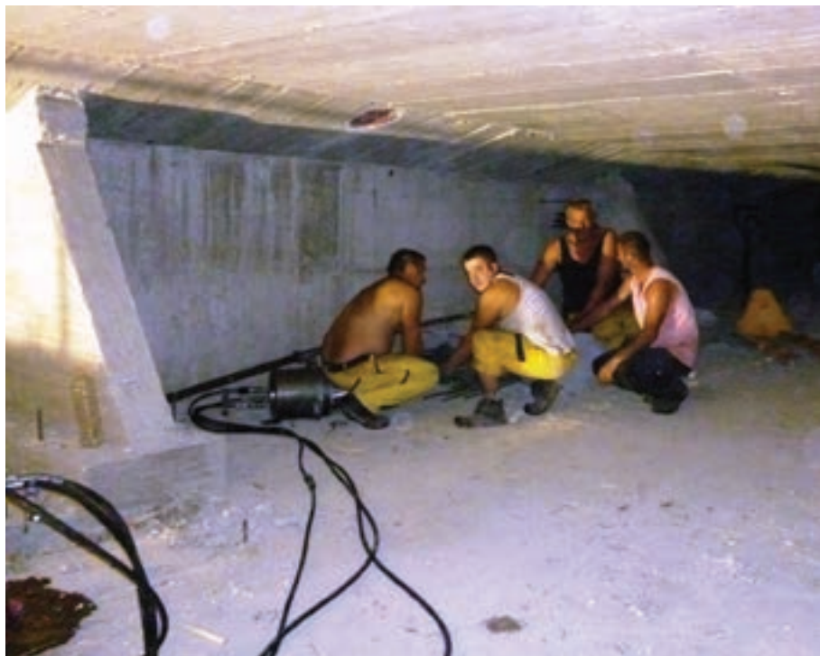
Slika 2.10: Prednapinjanje kablova donje ploče
