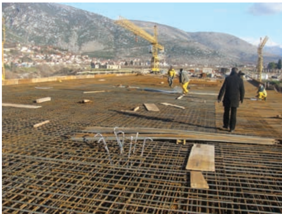
Slika 2.8: Armatura ploče prilaznog mosta
