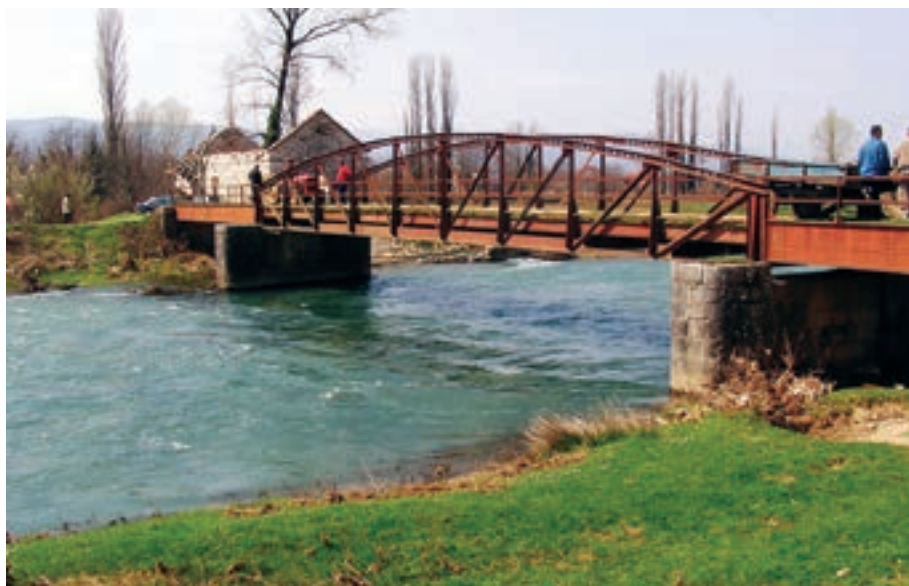
Slika 12.2: Pogled na konstrukciju mosta prije rekonstrukcije
