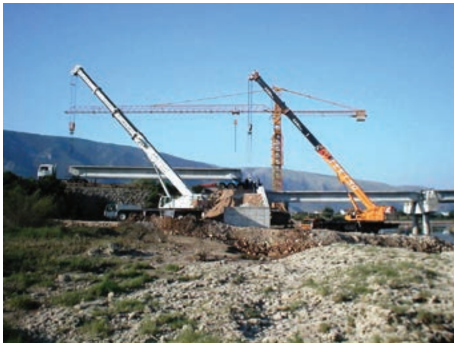
Slika 3.14: Montaža nosača kraćeg raspona
