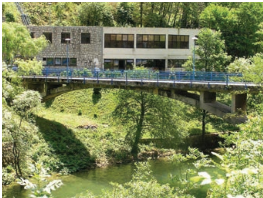
Slika 11.1: Pogled na most prije sanacije
