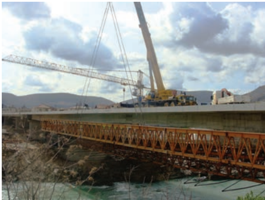
Slika 2.12: Demontaža čeličnih rešetki
