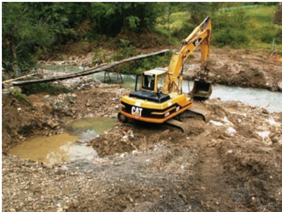
Slika 8.5: Iskop za desni upornjak
