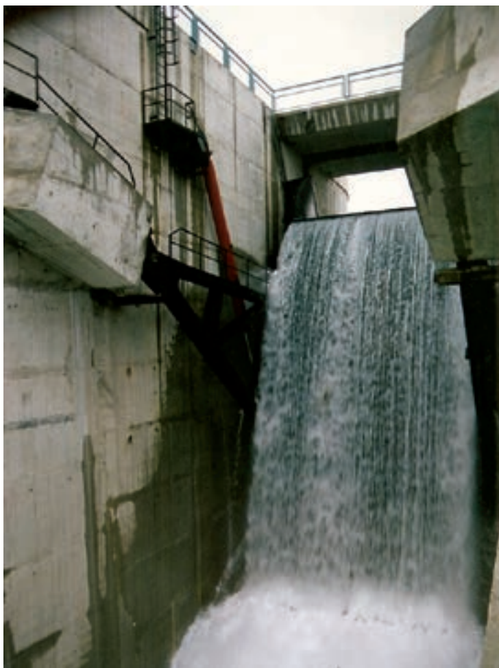
Slika 10.1: Pogled na prijelaz
