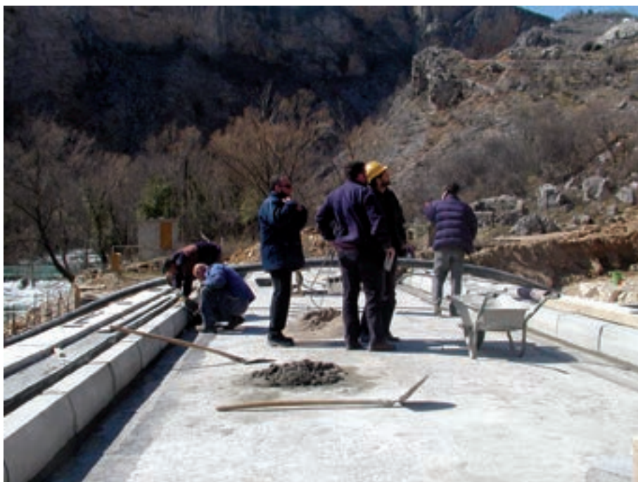
Slika 7.4: Postavljanje rubnjaka na mostu
