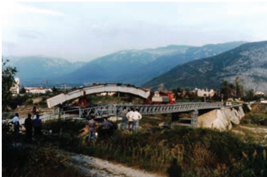
Slika 3.4: Prevoženje luka Carinskog mosta preko Bailey mosta 1995.
