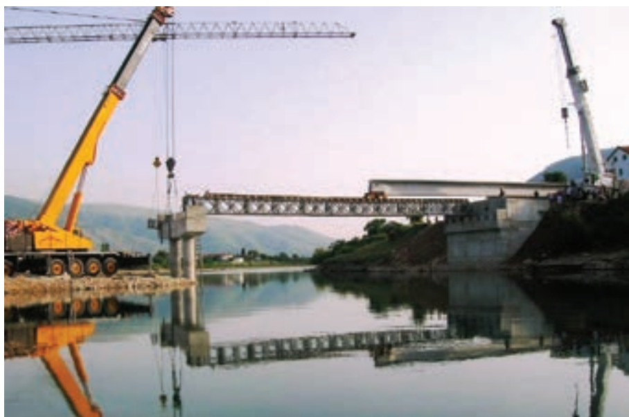
Slika 3.12: Navoženje nosača preko Bailey rešetke
