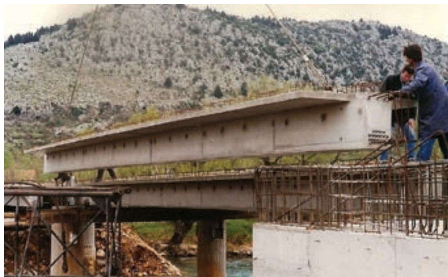
Slika 5.5: Montaža glavnih nosača
