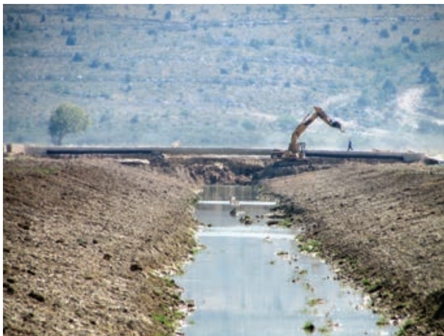
Slika 9.5: Iskop kanala ispod prijelaza
