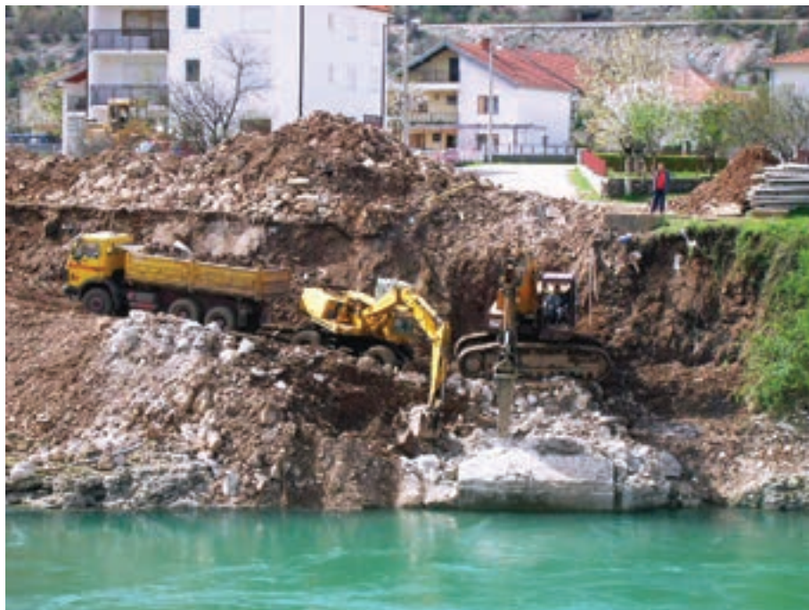
Slika 3.8: Uklanjanje desnog upornjaka
