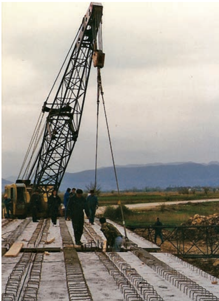
Slika 5.6: Završetak montaže glavnih nosača
