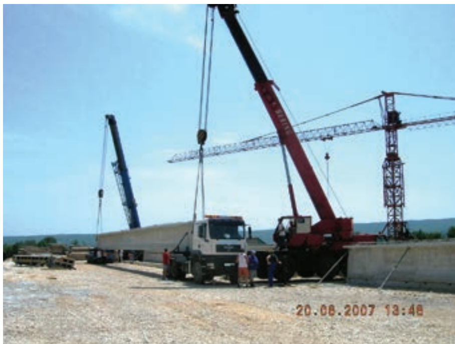
Slika 3.9: Utovar predgotovljenih nosača
