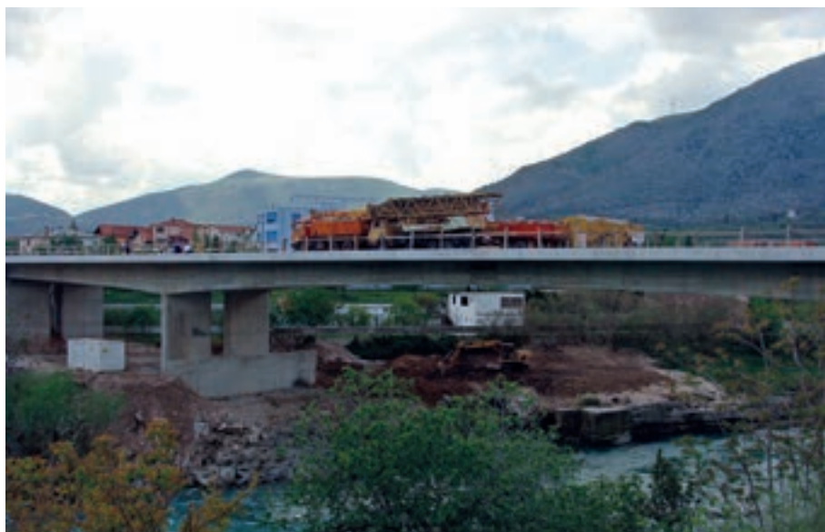
Slika 2.14: Ispitivanje mosta
