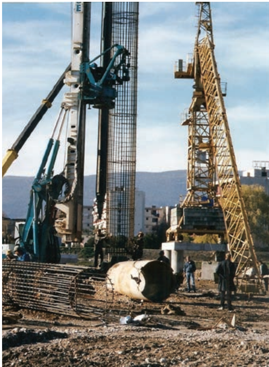
Slika 1.11: Izgradnja pilota na lijevoj obali ispod stupa glavnog raspona
