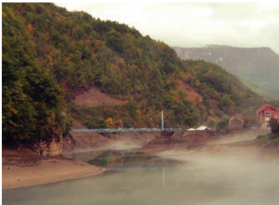
Slika 4.1: Pogled na most s uzvodne strane
