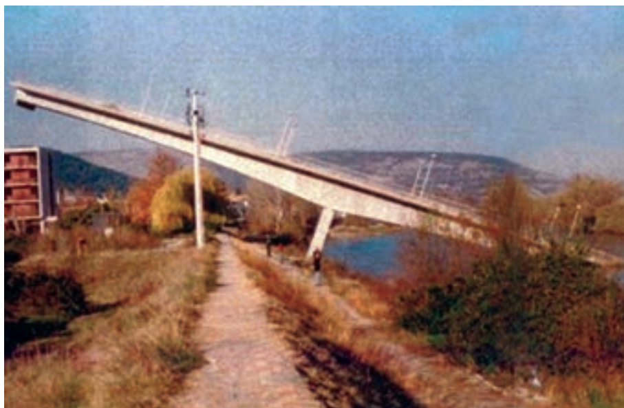
Slika 1.5: Zaokretanje mosta oko stupa na desnoj obali
