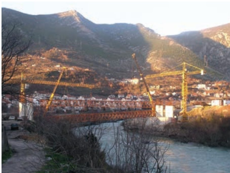
Slika 2.11: Montaža čeličnih rešetki na glavni raspon
