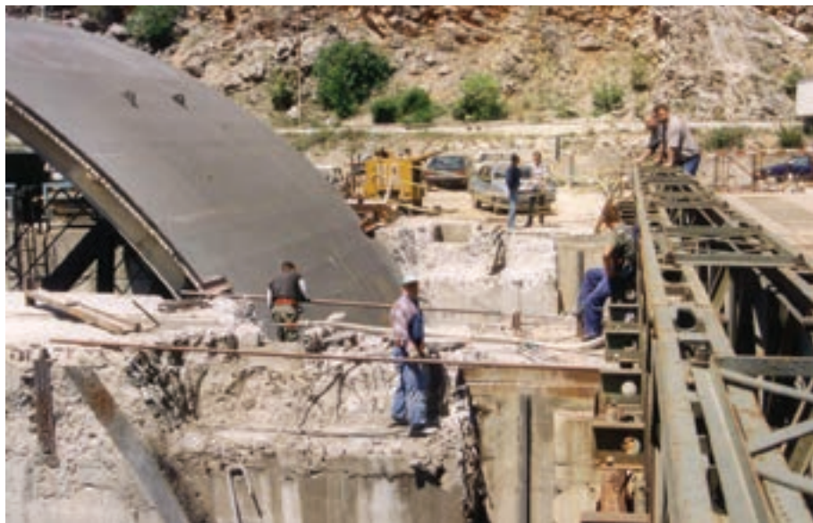
Slika 10.5: Priprema oslonca mosta
