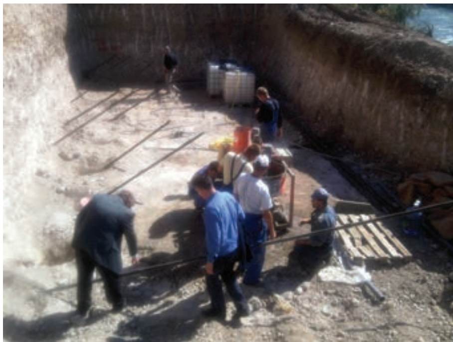
Slika 2.9: Izrada temelja riječnog stupa na lijevoj obali
