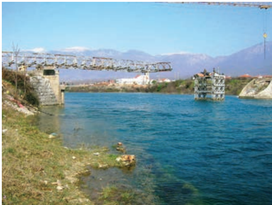
Slika 3.5: Demontaža Bailey mosta
