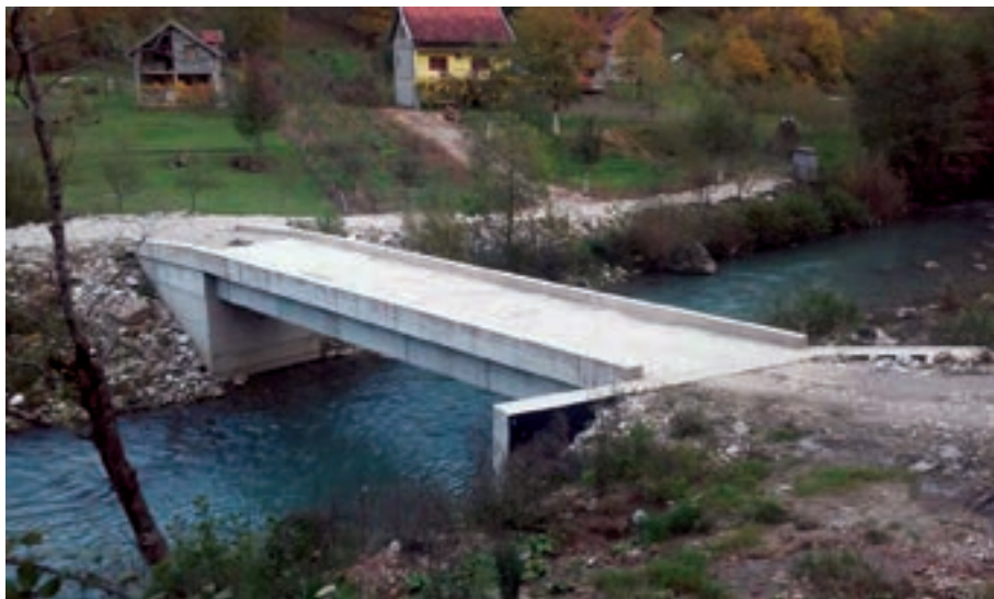
Slika 8.6: Pogled na most
