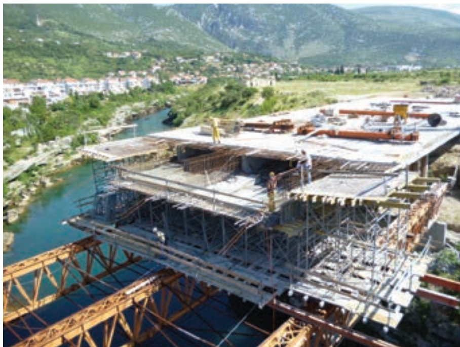
Slika 2.6: Izrada mosta u fazi III
