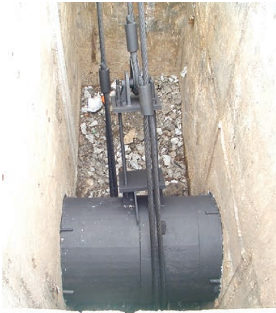
Slika 4.3: Način sidrenja kablova u upornjaku
