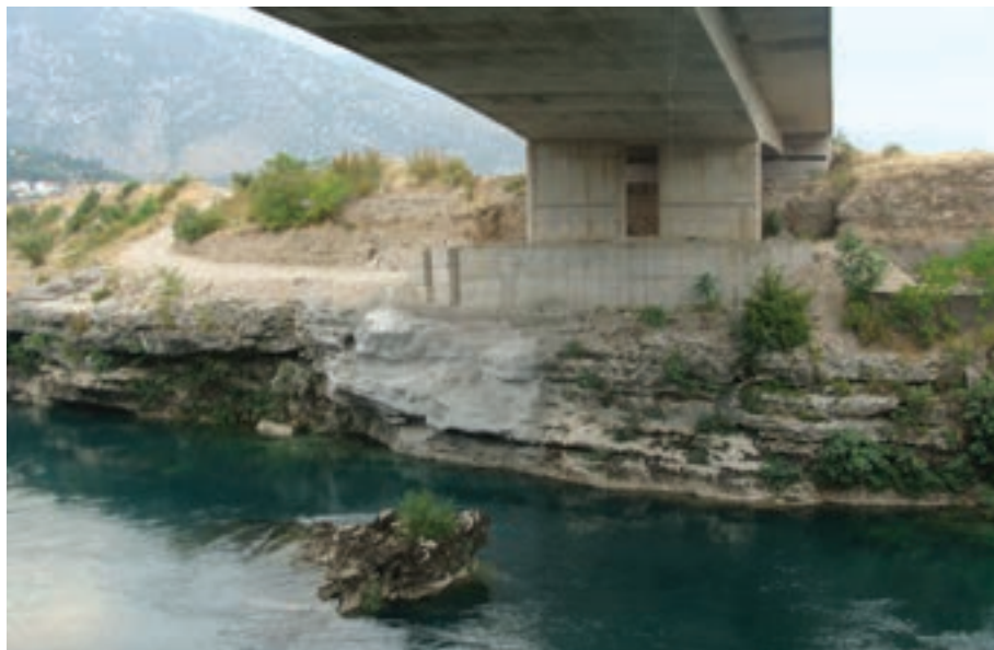
Slika 2.13: Torkretirana obala na lijevoj obali
