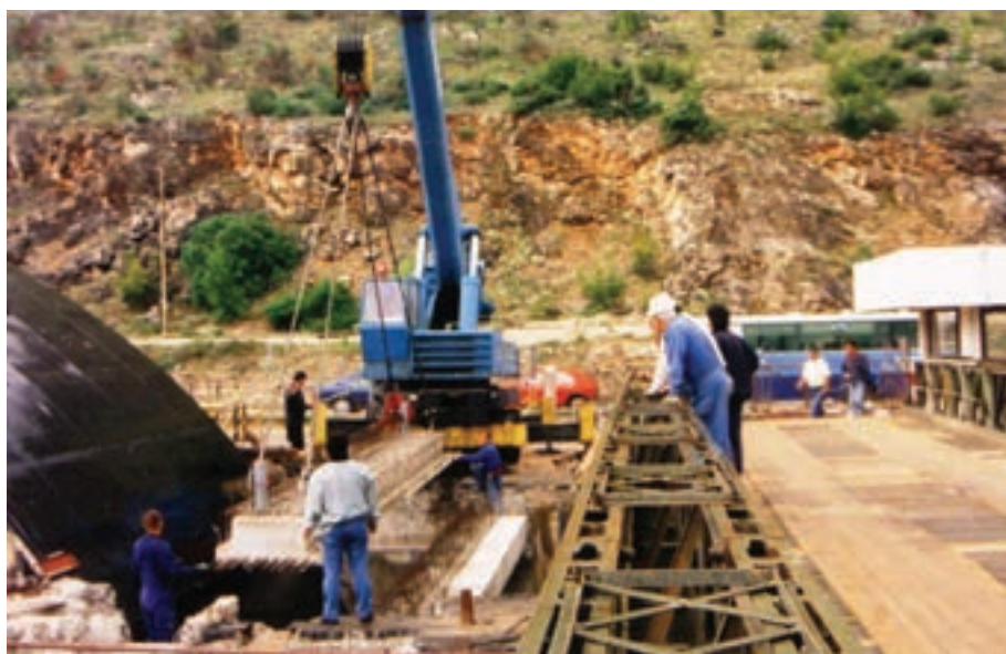
Slika 10.6: Postavljanje nosača, nizvodna polovica mosta
