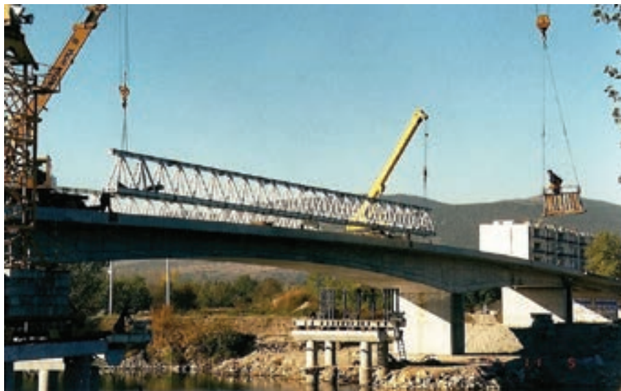
Slika 1.12: Uklanjanje čeličnih rešetki
