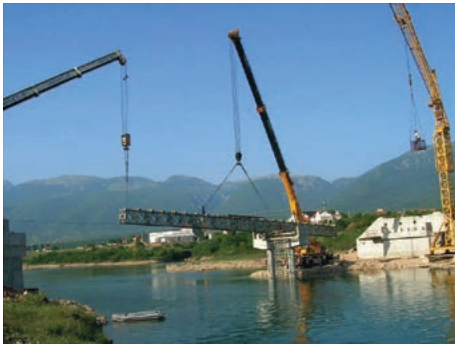
Slika 3.10: Montaža Bailey rešetke
