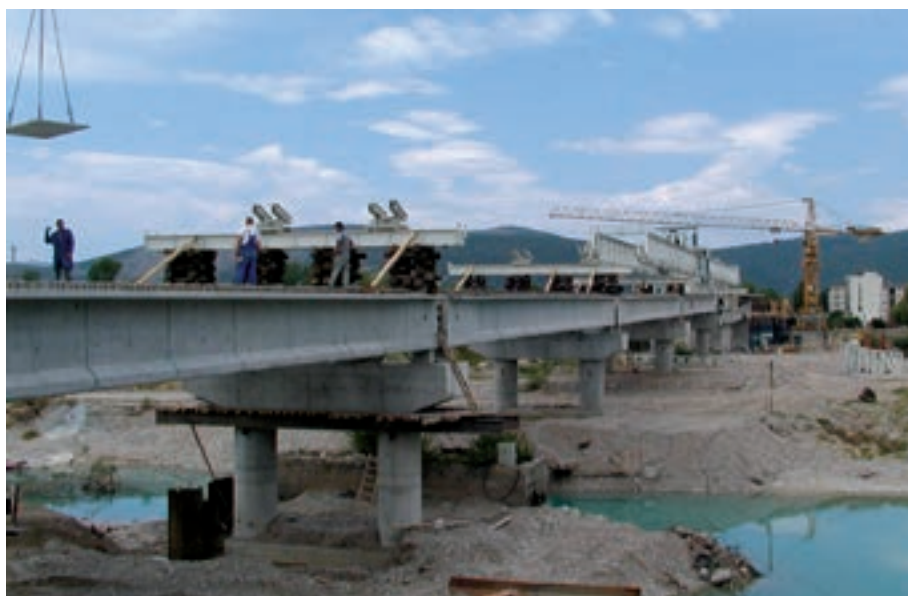
Slika 1.10: Navlačenje predgotovljenih nosača na dijelu mosta 5x32 m
