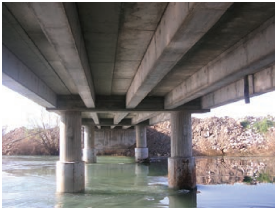
Slika 5.2: Donji ustroj mosta
