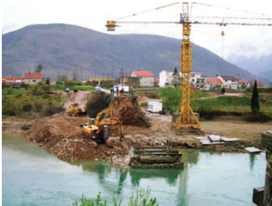
Slika 3.6: Uklanjanje temelja riječnog stupa
