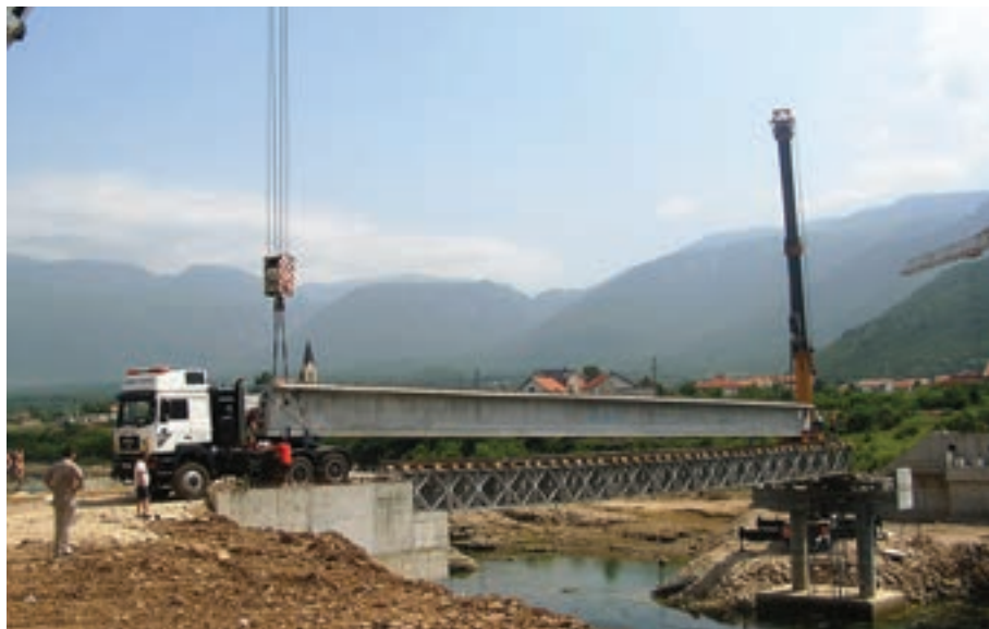
Slika 3.11: Montaža nosača dužeg raspona
