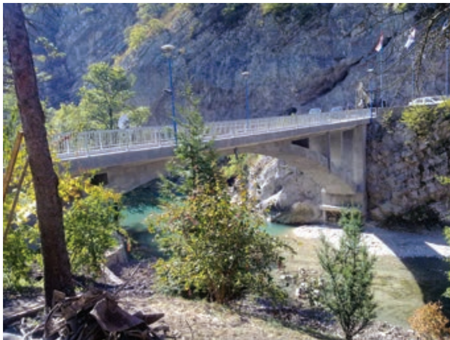
Slika 11.8: Pogled na most nakon sanacije
