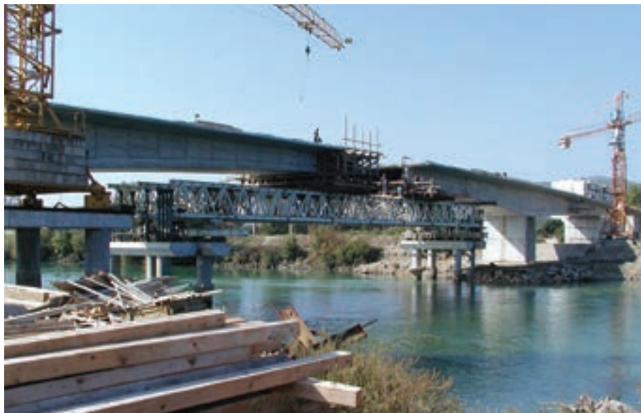
Slika 1.9: Prijepusno građenje pomoću čeličnih rešetki
