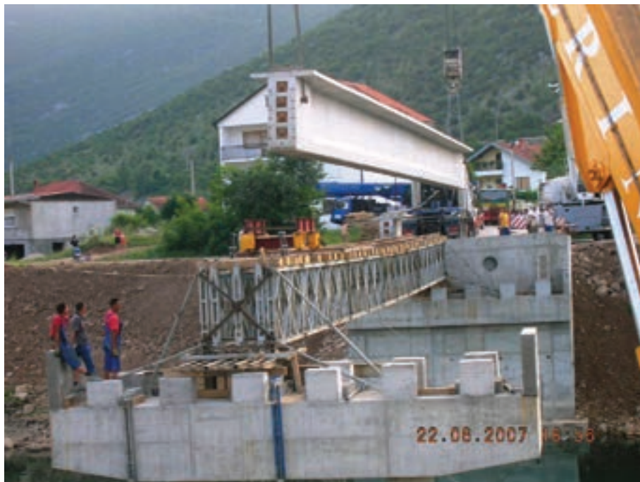
Slika 3.13: Postavljanje nosača na projektirani položaj
