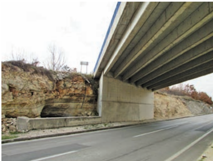
Slika 6.2: Upornjak, kaverna i predgotovljeni nosači
