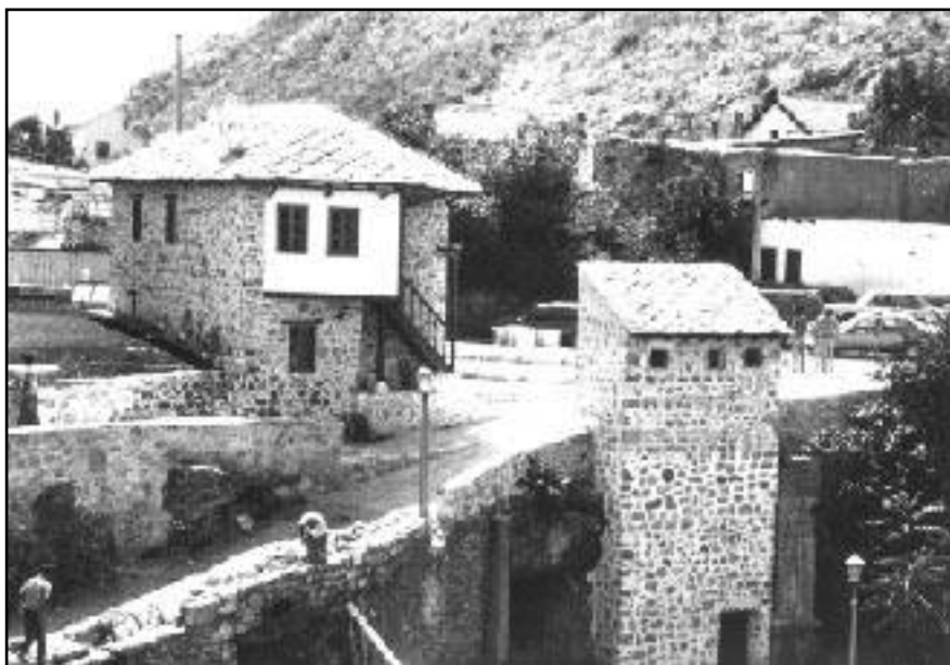
Mekteb i abdesthana nakon završene rekonstrukcije
