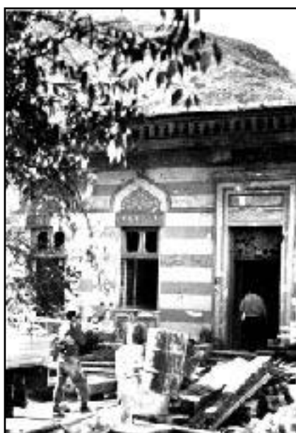
Mekteb u vrijeme sanacije
