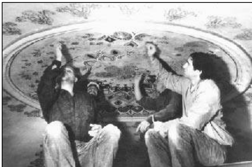
Sl.2 Rozeta u tjemenu kupole. Odstranjivanje austrijskog dekora i krečnih premaza
