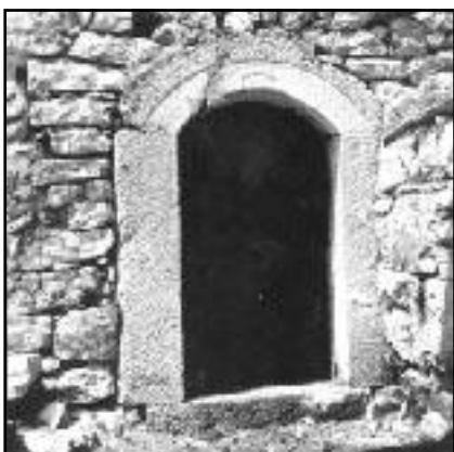
Sl.2 Detalj stambene zgrade: klesani okvir vrata sa lučno zasvođenim navojem Kružanj - Podveleže
