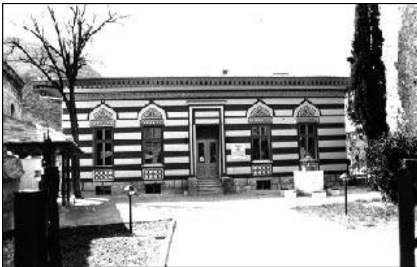
Džamija, mekteb, šadrvan nakon završenih radova
