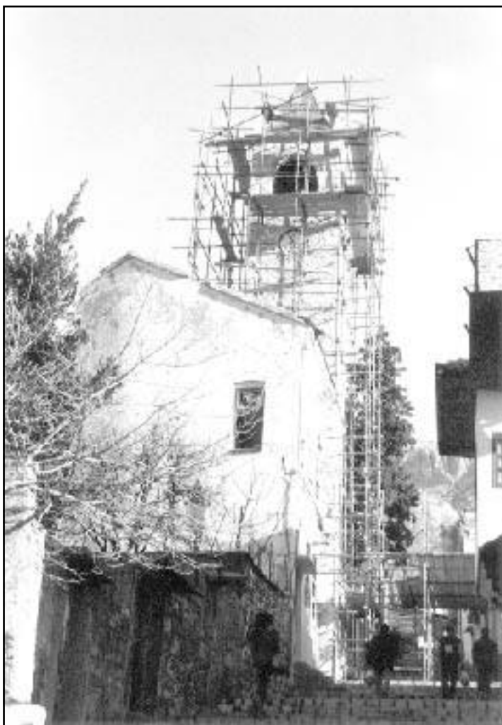
Sahat-kula u vrijeme sanacije
