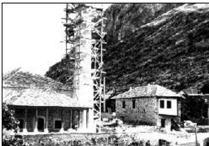
Kompleks Nezir-agine džamije pred kraj rekonstrukcije
