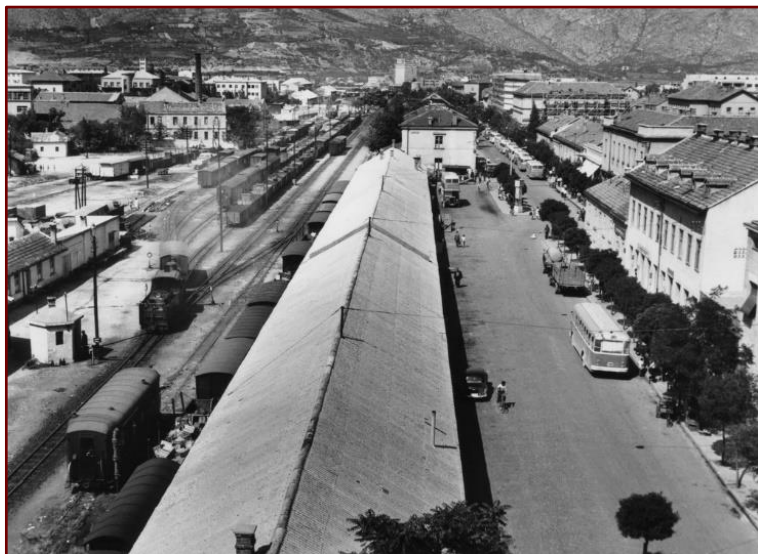
Stara željeznička stanica i željeznička skladišta, 1964. g.
