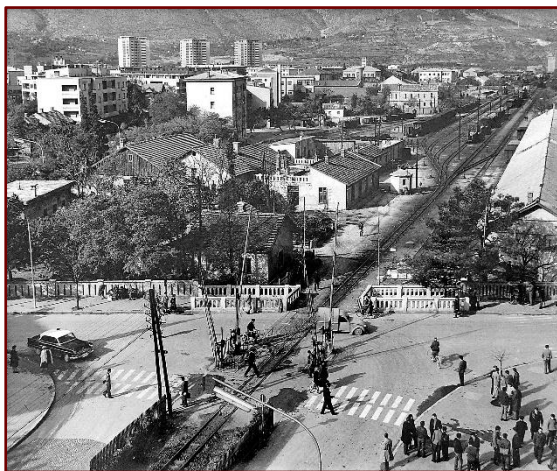
Rampa i podhodnik 1960-ih
