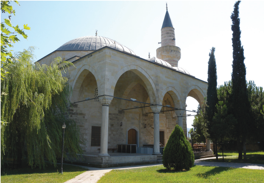
Plate 4: Restored Hersekzâde Ahmed Paşa Câmii in Dil (Hersek Köyü), 2011
