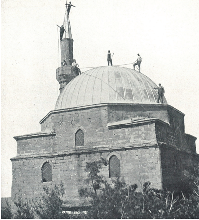
Resim 5: Hersekzâde Ahmed Paşa Câmii, 1930 Restorasyon Yapılırken
