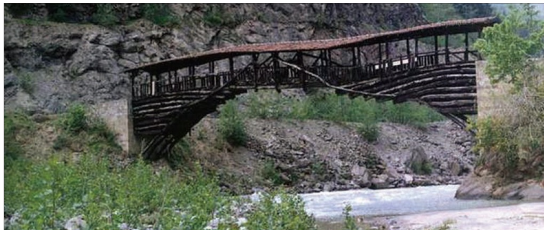
Drveni most, tzv. Kiremitli (ili Hapsiyaş) Köprüsü u pokr. Trabzon u Turskoj iz 1935. godine
