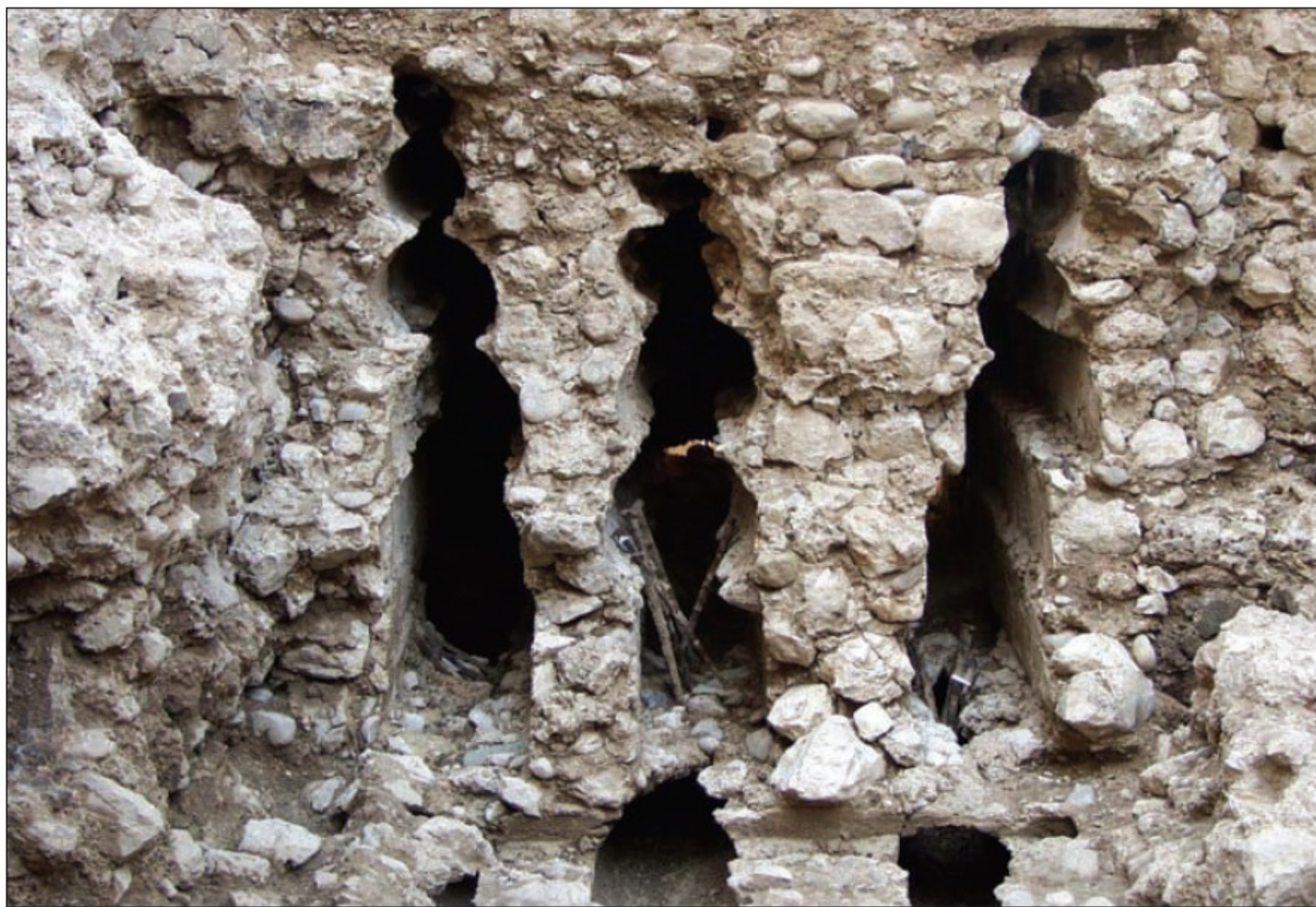
Masivni željezni klinovi drvenoga kasnosrednjovjekovnoga mosta, preostali u šupljinama zidova
